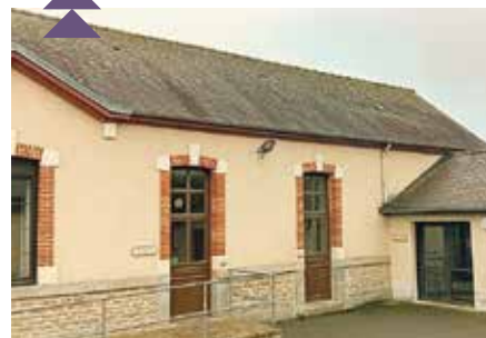
Rénovation énergétique des salles Jean Le Duc et Jean Gilbert de Quédillac (MOD)
