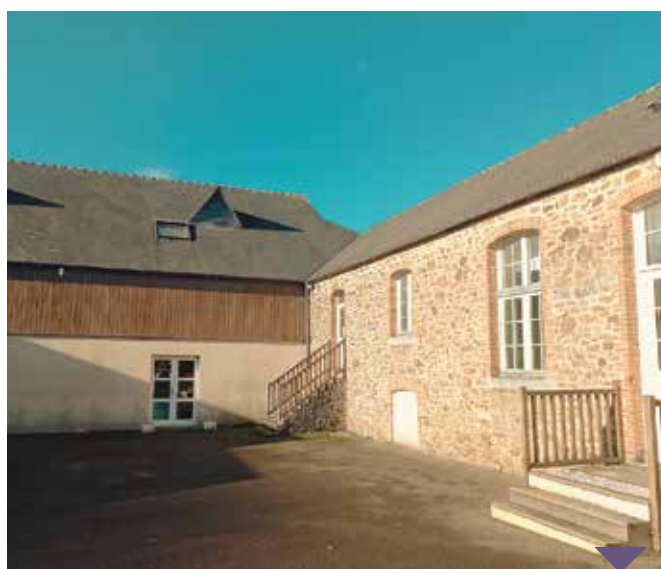
Rénovation énergétique de la salle l'Atrium de Romagné (MOD)
