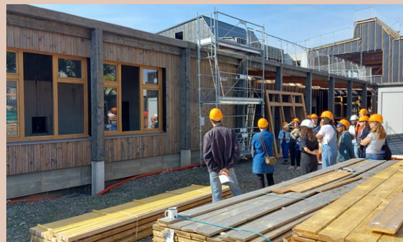
/ La visite du chantier, en septembre 2025.
