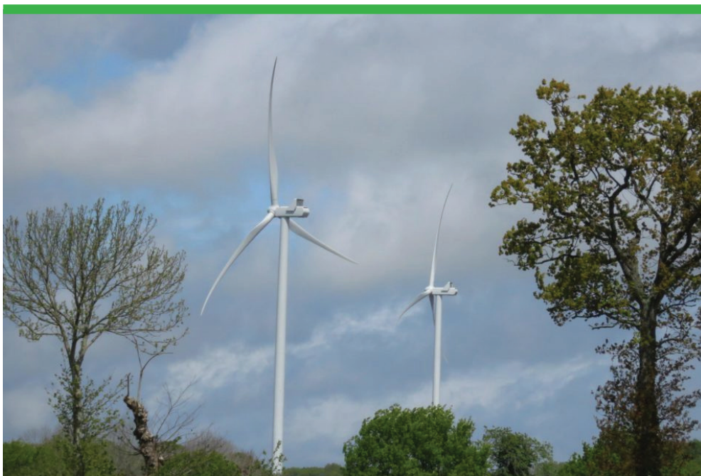
Deux des quatre mât installés dans le parc éolien de Bazougeais.
