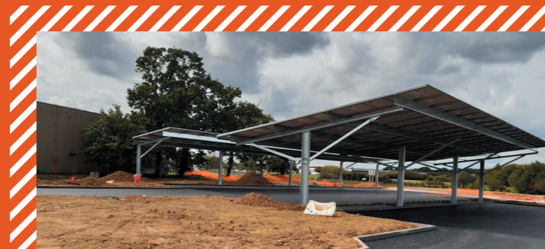
1 ère ombrière installée à Saint-Aubin-du-Cormier
