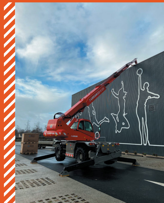
Salle des sports de Bréal-sous-Montfort
