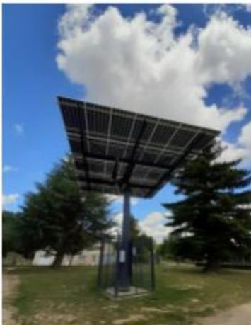
Placé sur un poteau pivotant de 3,5 mètres de haut, le tracker compte 75 m<sup>2</sup> de panneaux solaires permettant de produire 19 MWh par an. ©Énerg'IV.
