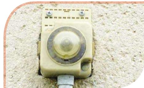
En moyenne, un éclairage permanent commandé par interrupteur crépusculaire bien positionné représente un temps de fonctionnement de 4 400 heures par an.
